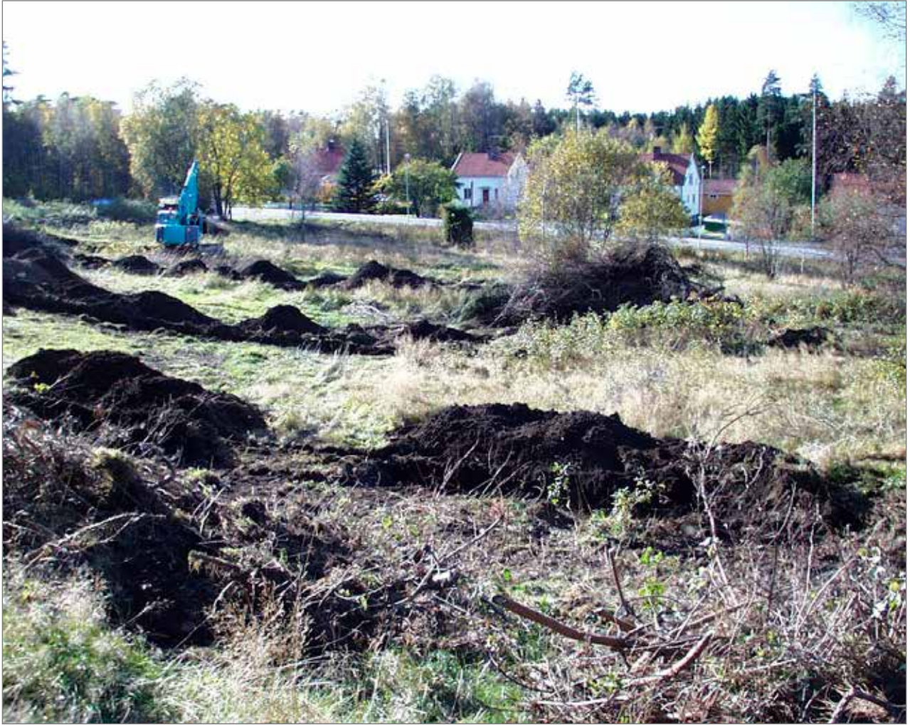
Figur 6. Schaktning med grävmaskin mot nordost. Foto Stig Swedberg, Bohusläns museum.
