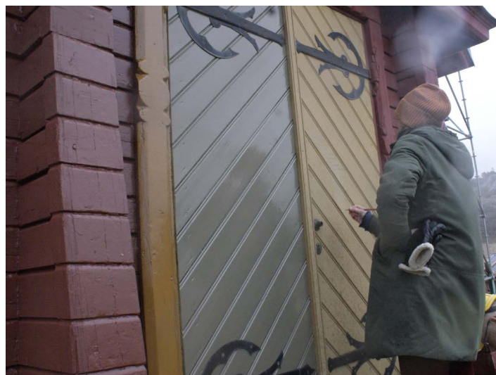
Uppstrykningsprover på Hälleviksstrands kyrka inför beslut om färgsättning.
