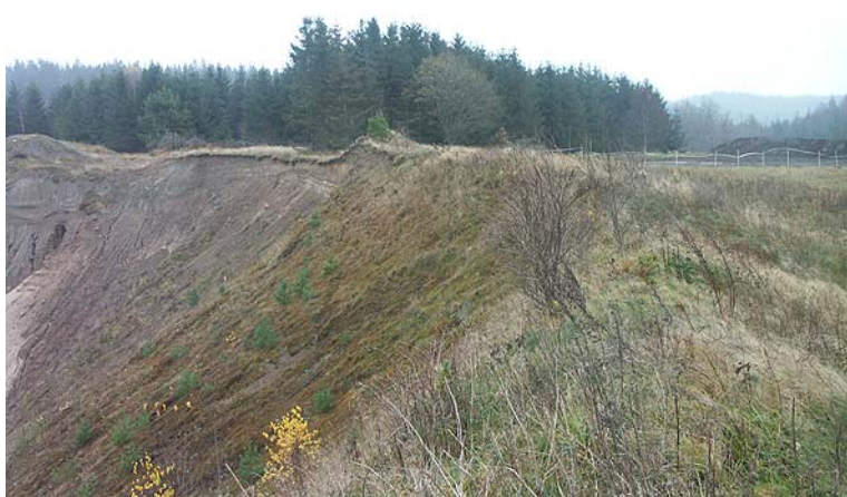
Tätkanten vid utsättningstillfället, västra delen. Täktvallarna fortfarande intakta, täktväggen delvis igenvuxen.
