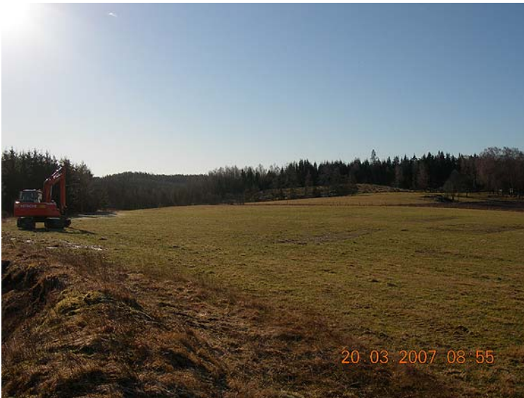
Översikt över Ucklum 217 före silschaktgrävning. Västra änden av tätkantsvallen synlig nere till vänster i bild.
