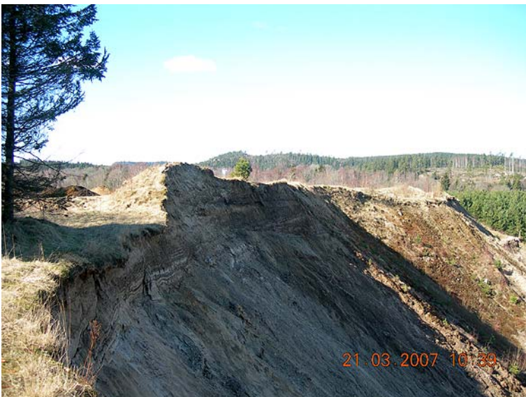
Tätkanten från norr. Bakom tätkvallarna anas dumpmassorna från sökschakten. Notera bortre tätkant som börjar växa igen.
