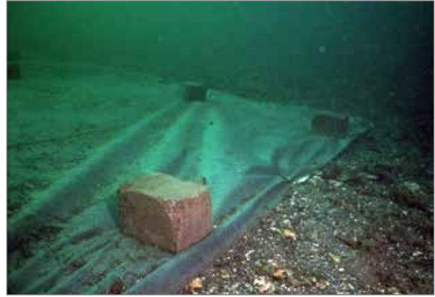
Figur 2. Sydvästra hörnet av skyddstäckningen. Fotot taget i samband med etableringen av erosionskyddet i november 2009. Foto Staffan von Arbin, Bohusläns museum.
