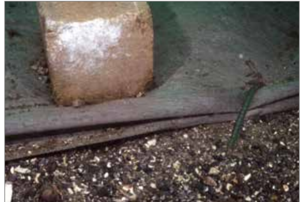
Figur 3. Detaljbild av fiberduk, viktsten och förankringsjärn. Foto från etableringen av skyddet i november 2009. Foto Staffan von Arbin, Bohusläns museum.
