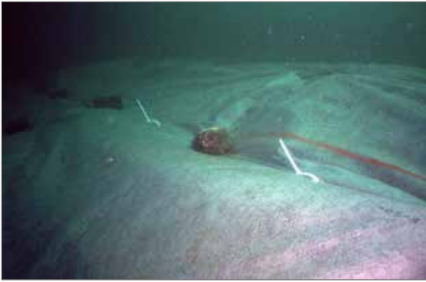
Figur 4. Skarven mellan de två våderna fiberduk »syddes« ihop med hjälp av buntband. Foto taget i november 2009. Foto Staffan von Arbin, Bohusläns museum.
