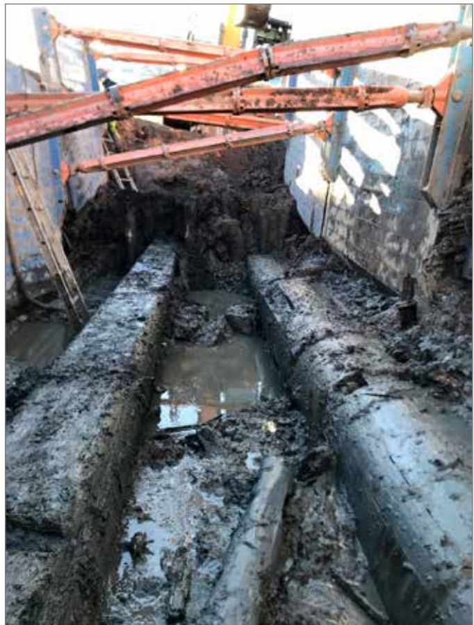
Figur 9. Översiktsbild mot S över de båda mastdelarna 566 och 575 in situ i botten av pirkonstruktionen (ingår i KG 19). I bakgrunden ser man hur de fortsätter in under den Ö-V-gående spanten (KG 18). Foto: Veronica Forsblom Ljungdahl, Bohusläns museum.
