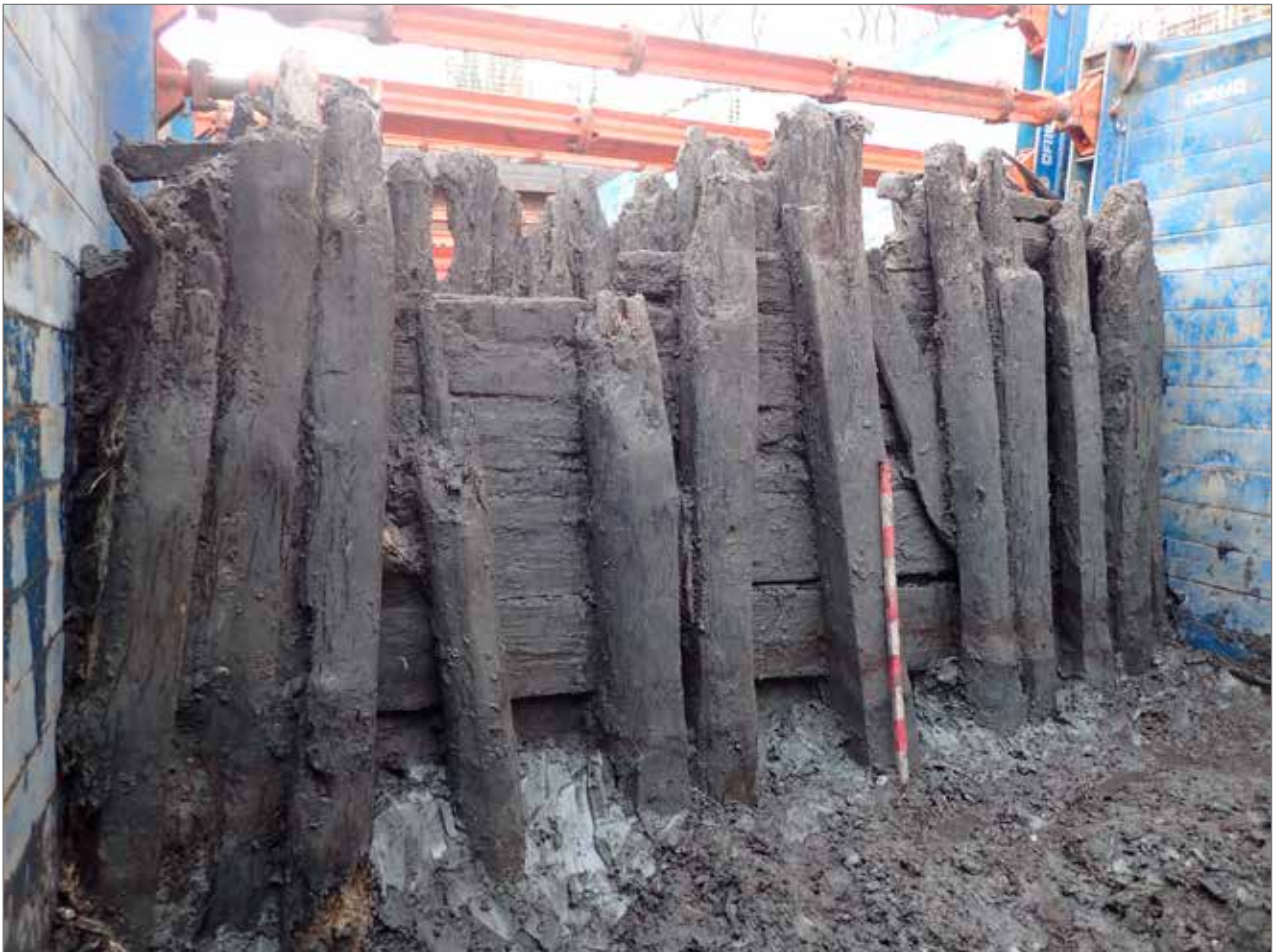
Figur 10. Del av den västra Ö-V-gående sponten (KG 4) efter framrensning, mot S. I nedre delen av sponten syns rester av tjocka lerlager som påförts som utfyllnad. Foto: Veronica Forsblom Ljungdahl, Bohusläns museum.
