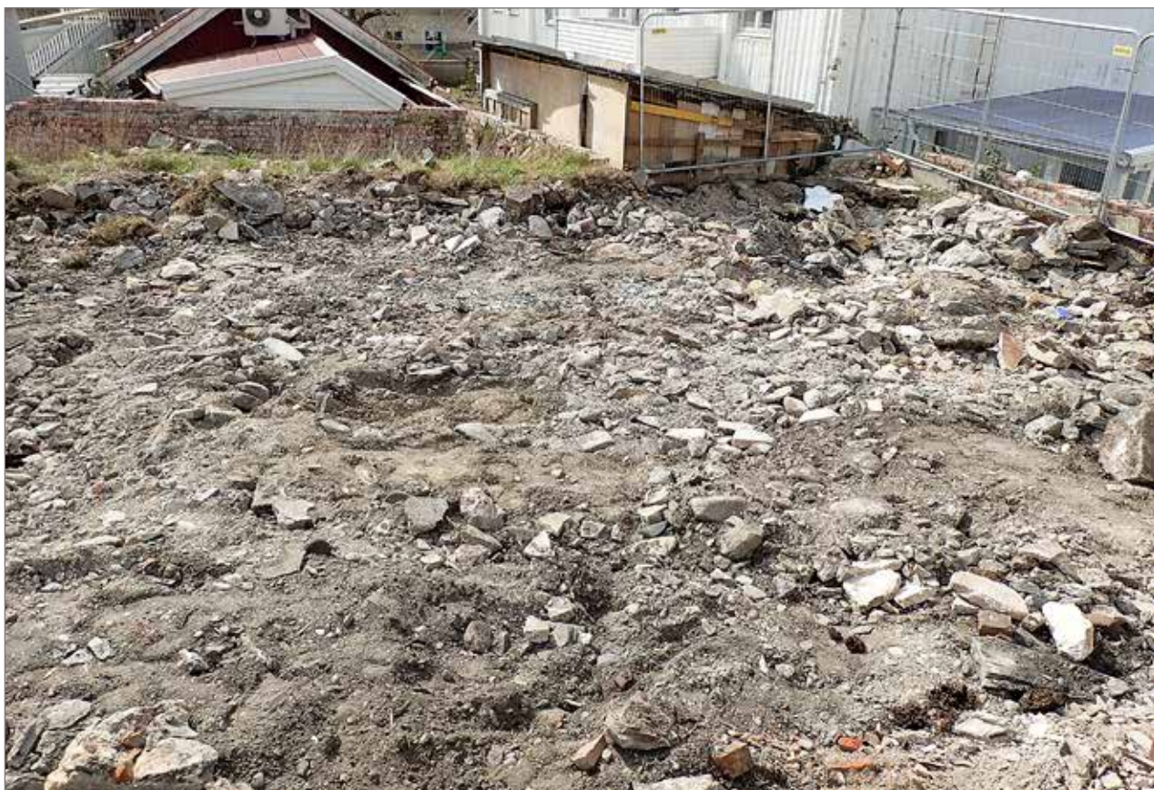
Figur 12. Den avrivna betongplattan inom yta B, söder om Isboden. Vy mot söder. Foto Thomas Bergstrand, Bohusläns museum.
