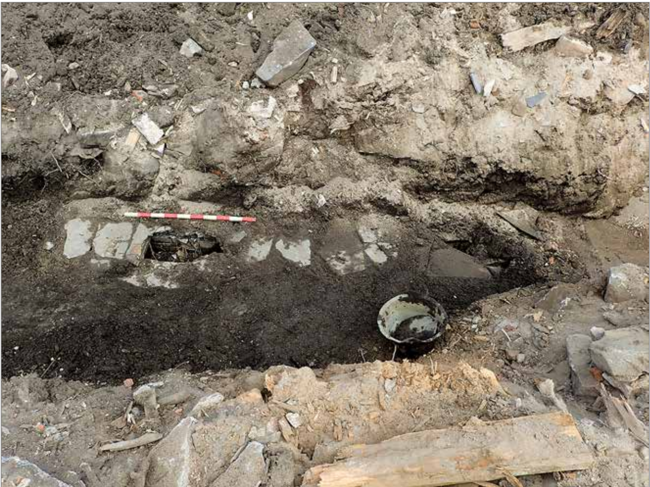
Figur 39. Kulvert byggd av skifferplattor inom yta D. Vy mot nord. Foto Thomas Bergstrand, Bohusläns museum.
