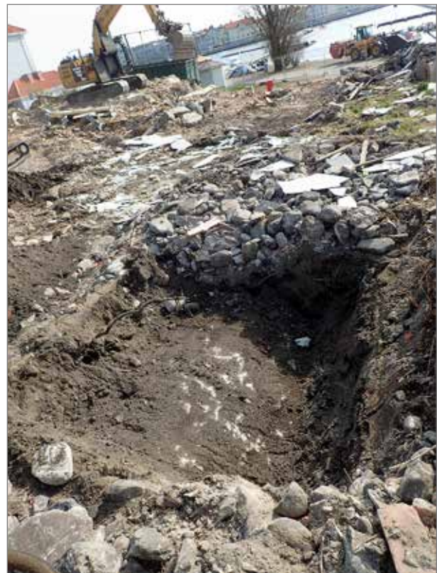
Figur 14. Schakt 3 inom yta C under en mindre betongplatta. Berggrunden låg här väldigt ytlig. Vy åt öster. Foto Thomas Bergstrand, Bohusläns museum.
