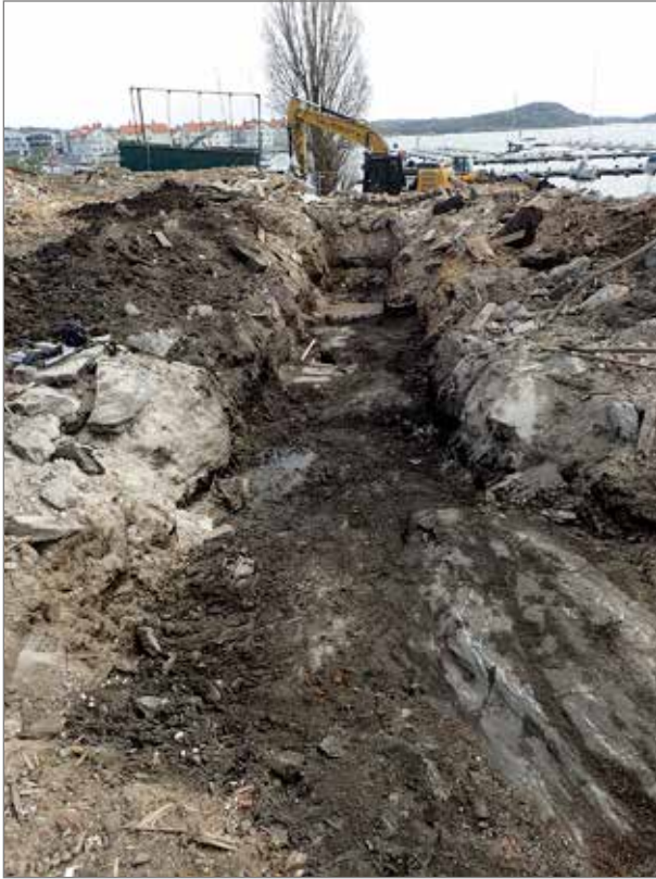
Figur 15. Schakt 4 inom yta D. Där 1700-talshuset tidigare hade stått framkom en vattenkulvert som var anlagd i anslutning till den ytliga berggrunden. Vy åt öster. Foto Thomas Bergstrand, Bohusläns museum.
