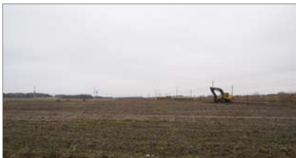
Figur 11. Översikt över Värö 344 från söder. Höjdryggens krön kan anas till vänster om grävmaskinen. Foto: Mattias Öbrink.
