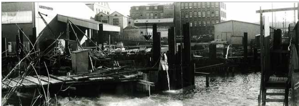
Figur 8. Byggnationen av spårvägsbron 1971. Centralt i bilden står den spontade kofferddamm i vilken delar av fartygslämningen påträffades. Foto: Göteborgs stadsmuseum.
