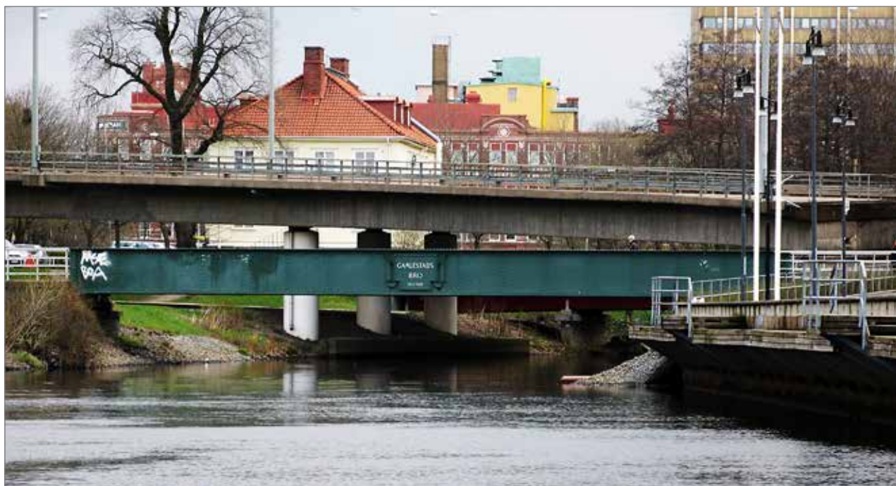
Figur 11. Säveån med vy uppströms förundersökningsområdet. De båda broarna är dels den lägre gång- och cykelbron och dels körbron för Gamlestadsvägen. Den senare utgjorde gränsen uppströms för undersökningen.
