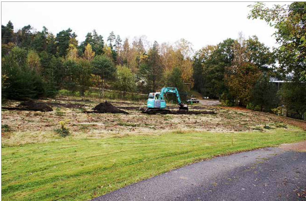
Figur 54. Bilden visar norra delen av förundersökningsområdet där man strax innan avverkat ett tätt bestånd av unga granar. Den enda härden som hittades på Herrestad 161 låg ganska precis vid grävmaskinens skopa. På berget strax bakom huset i bakgrunden ligger en annan förundersökt boplats, Herrestad 419. Foto mot nordnordost, Robert Hernek.
