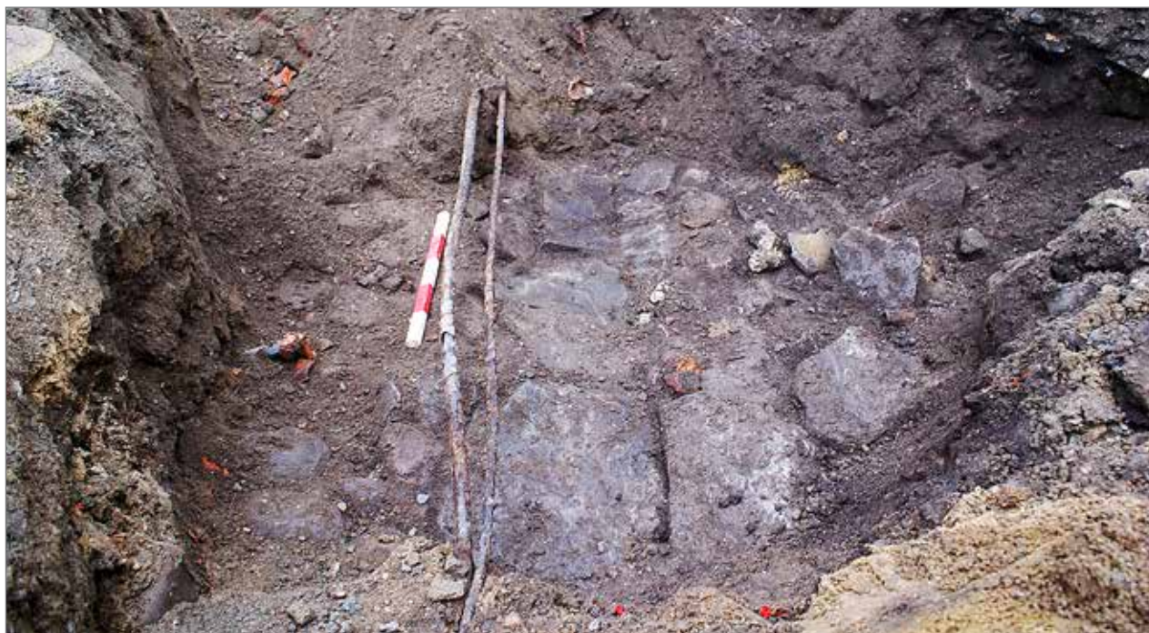
Figur 9. Snedfoto över rännstenen och gatubeläggningen A6 i S12. Schaktet korsas av äldre ledning vars nedgrävning dock inte stört rännstenen. Foto från söder: Magnus Rolöf.
