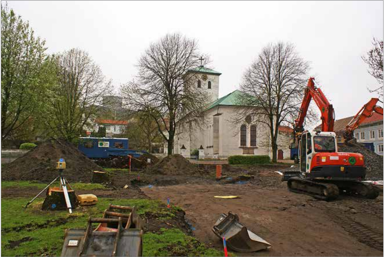
Figur 3. Översikt över norra delen av Stadsparken under schaktningsarbeten med kyrkan och fästningen i bakgrunden. Foto från öster: Magnus Rolöf.
