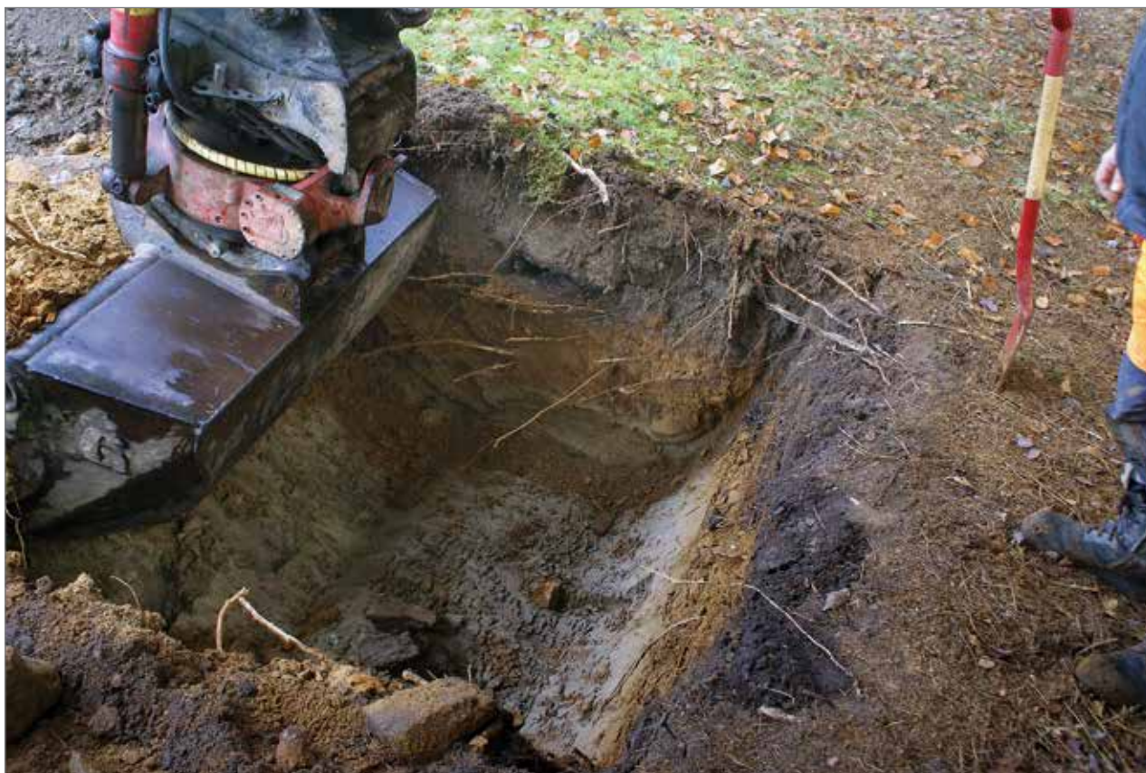
Figur 8. Översiktsfoto schakt. Foto från sydväst: Joakim Åberg.
