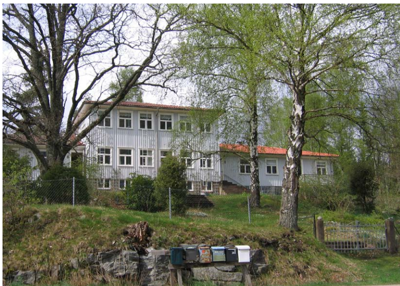
Ovan: Alingsås skollovskoloni, Bokenäs, Uddevalla kommun. Efter att ha hyrt in sig på olika platser sedan 1912 byggdes 1943 denna anläggning. Den liknar Götaverkens anläggning (se bild förra sidan) som ligger i närheten, och det var också samma byggmästare till båda anläggningarna. Foto Katarina Andersson, Bohusläns museum.
