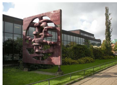
Walkesborgsbadet i Uddevalla från 1975. De stora glasytorna ger anläggningen mycket ljus och är en viktig del av den arkitektoniska gestaltningen. Utanför entrén finns ett tidstypiskt konstverk. Foto Tomas Brandt, Bohusläns museum.
