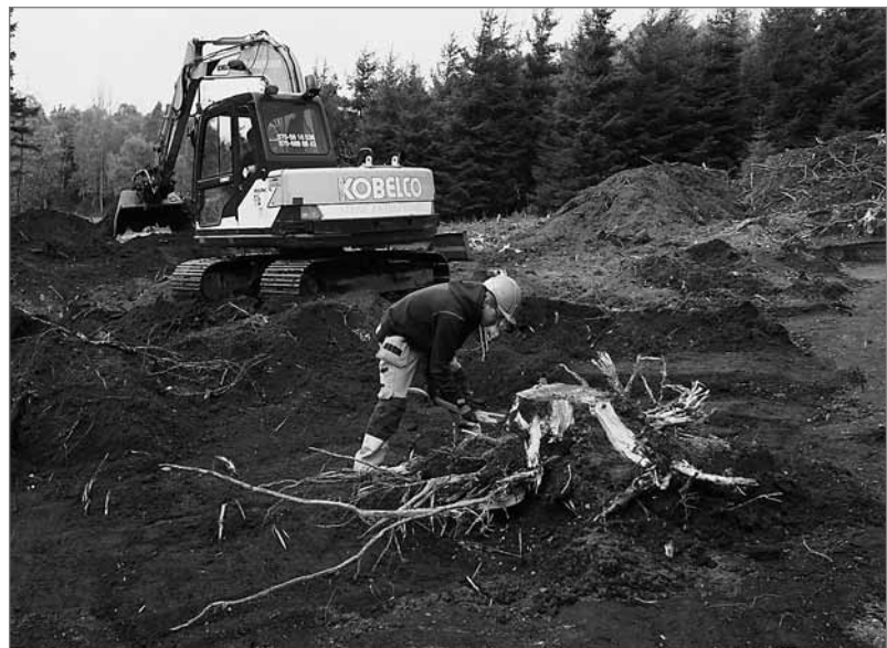
Figur 5. Anläggningar framträder i samband med schaktning. Markus Andersson i förgrunden. Foto mot nordväst: Per Falkenström.
