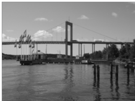
Figur 4. Förundersökningsområdet mot sydväst med den i texten omtalade pirkonstruktionen synlig mitt i bilden. I bakgrunden syns Ålvsborgsbron. Foto Erik Cardell, Sweco Environment AB.
