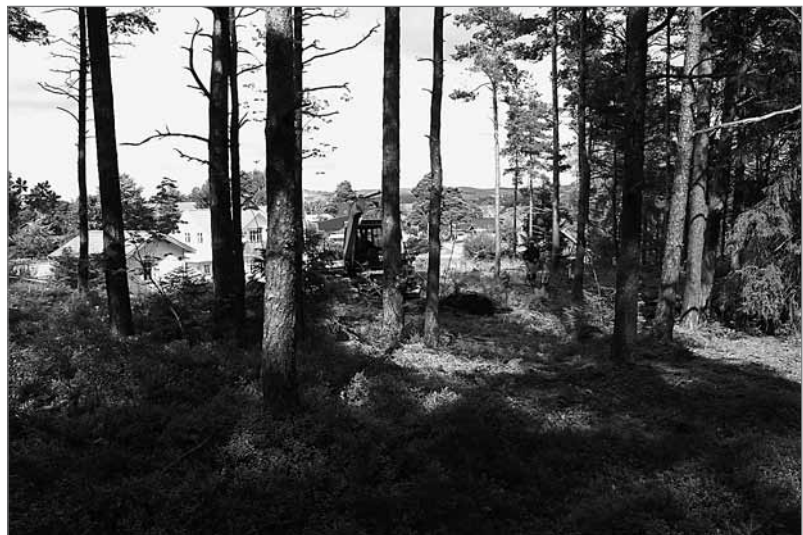
Figur 10. Boplatsen Morlanda 549 som en gång har haft en vid utsikt. Igenläggning av schakt 26 pågår. Foto mot nordöst, Oscar Ortman.
