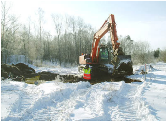
Grävmaskiner används för att ta bort snön och det översta marklagret
