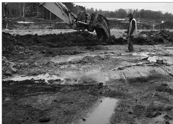
Figur 14. Arbetsbild från Kareby 137. Schaktning pågår. Foto från öster Joakim Åberg.
