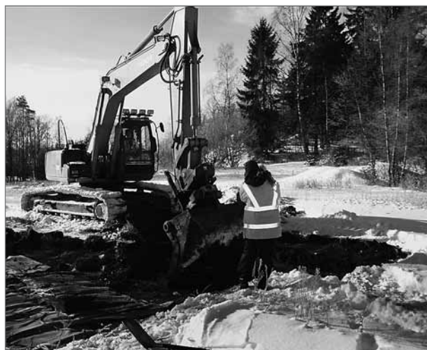
Figur 10. Arbetsbild från Kareby 136. Inledande schaktning. Foto från norr Joakim Åberg.
