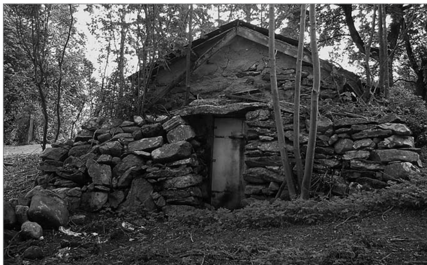
Figur 17. Den kallmurade källaren vid Ödsmål 14:1 mot öster. Foto Martin Gollwitzer.
