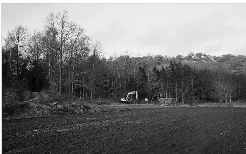
Figur 8. Vy över platsen för Objekt 1. Foto från söder: Per Falkenström.
