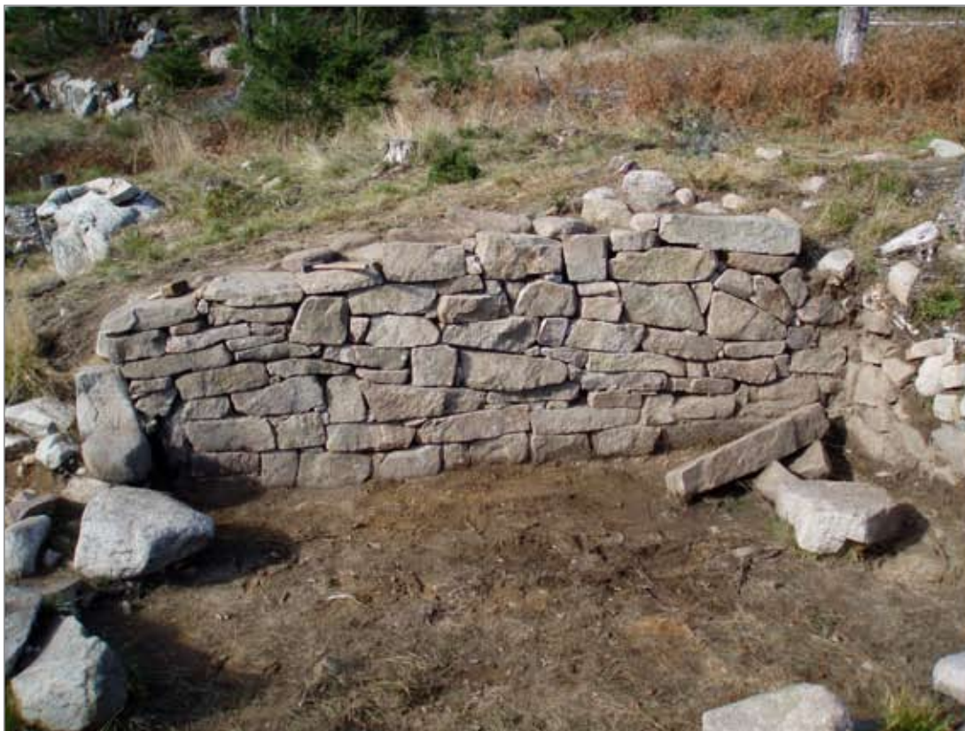
BILAGA 4. Den nya muren återupbyggdes till samma nivå som den östra muren.
