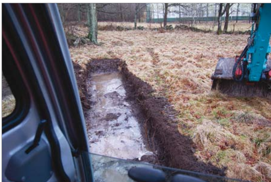
Figur 7. Schakt vid fornlämning 16:2. Direkt efter att schaktet tagits upp tränger grundvatten fram och försvårar dokumentationen. Foto Martin Gollwitzer.
