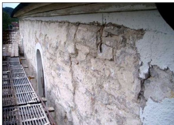
Foto från byggnadsställningen.
