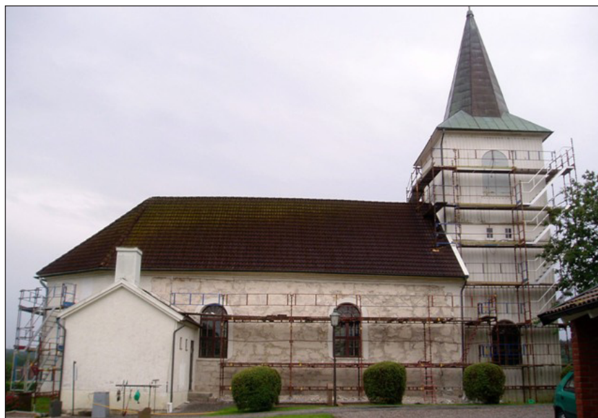
Håby kyrka från norrsidan, under pågående ommålning och putsningsarbeten. Augusti 2007.
