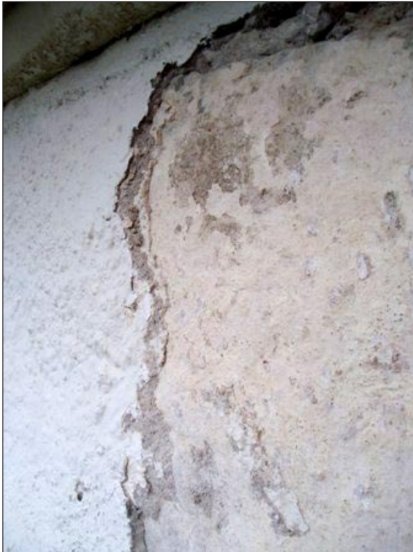
Ovan: Kyrkans putslager: Ytterst mörkfärgad cementhaltiga putslagningar, därefter kalkspritputs, och underst den beigegula kalkfärgen direkt på stenen.
