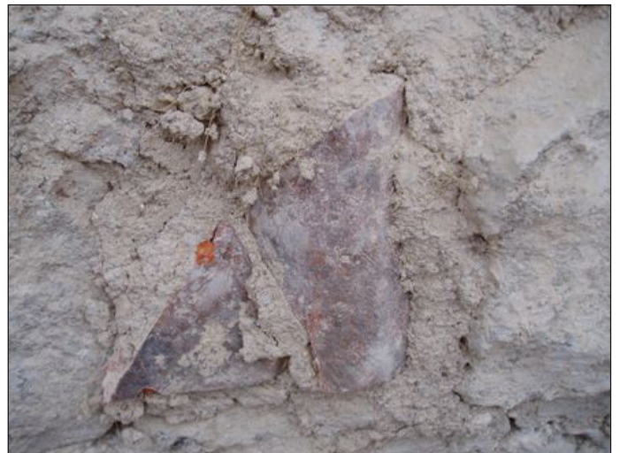
Ovan: Kyrkans putslager: Ytterst mörkfärgad cementhaltiga putslagningar, därefter kalkspritputs, och underst den beigegula kalkfärgen direkt på stenen.
