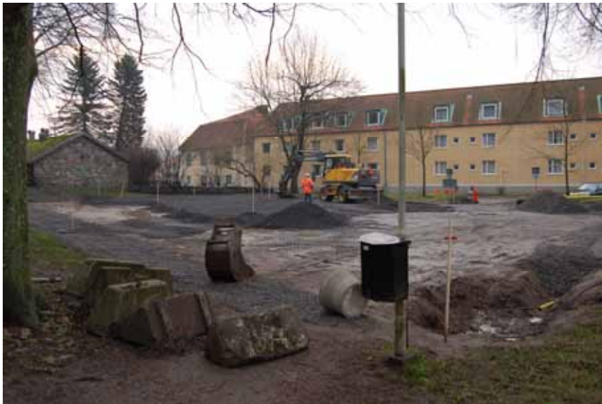
Bild 2. Kungälv Alarmposten vid den 08-04-03. Man ser tydligen att över stora ytor av undersökningsområdet är det redan lagt ut grus och asfalt och alla schakten är igenfyllda. Vy mot sydväst.
