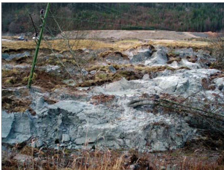
Figur 5. Vy över skredet i Småröd. Bilden är tagen från åkern en bit söder om Foss 237. Under leran ligger järnvägsspåren. Efter omläggning av spåret öppnades Bohusbanan åter för trafik den 24 februari. Den var således avstängd i sextiosex dagar. Foto mot väster, Robert Hernek.
