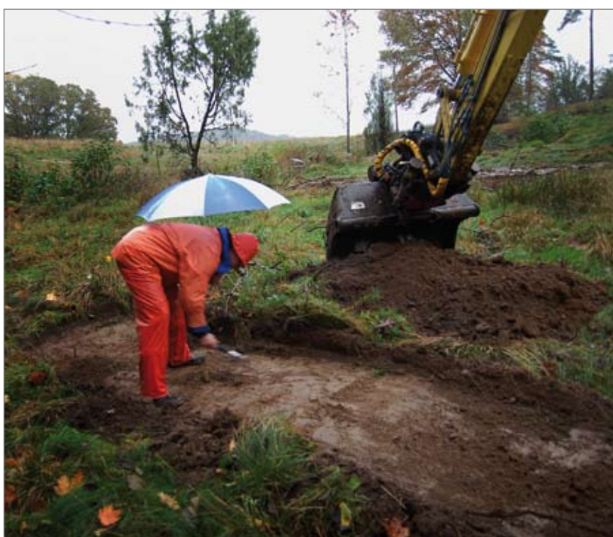
Figur 5. Robert Hernek schaktar i anslutning till Ljung 139. Foto från sydväst: Per Falkenström.
