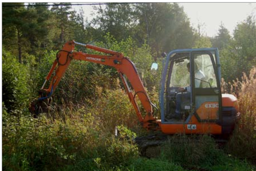
Figur 6. Schaktning i snårig terräng. Foto från väster: Per Falkenström.
