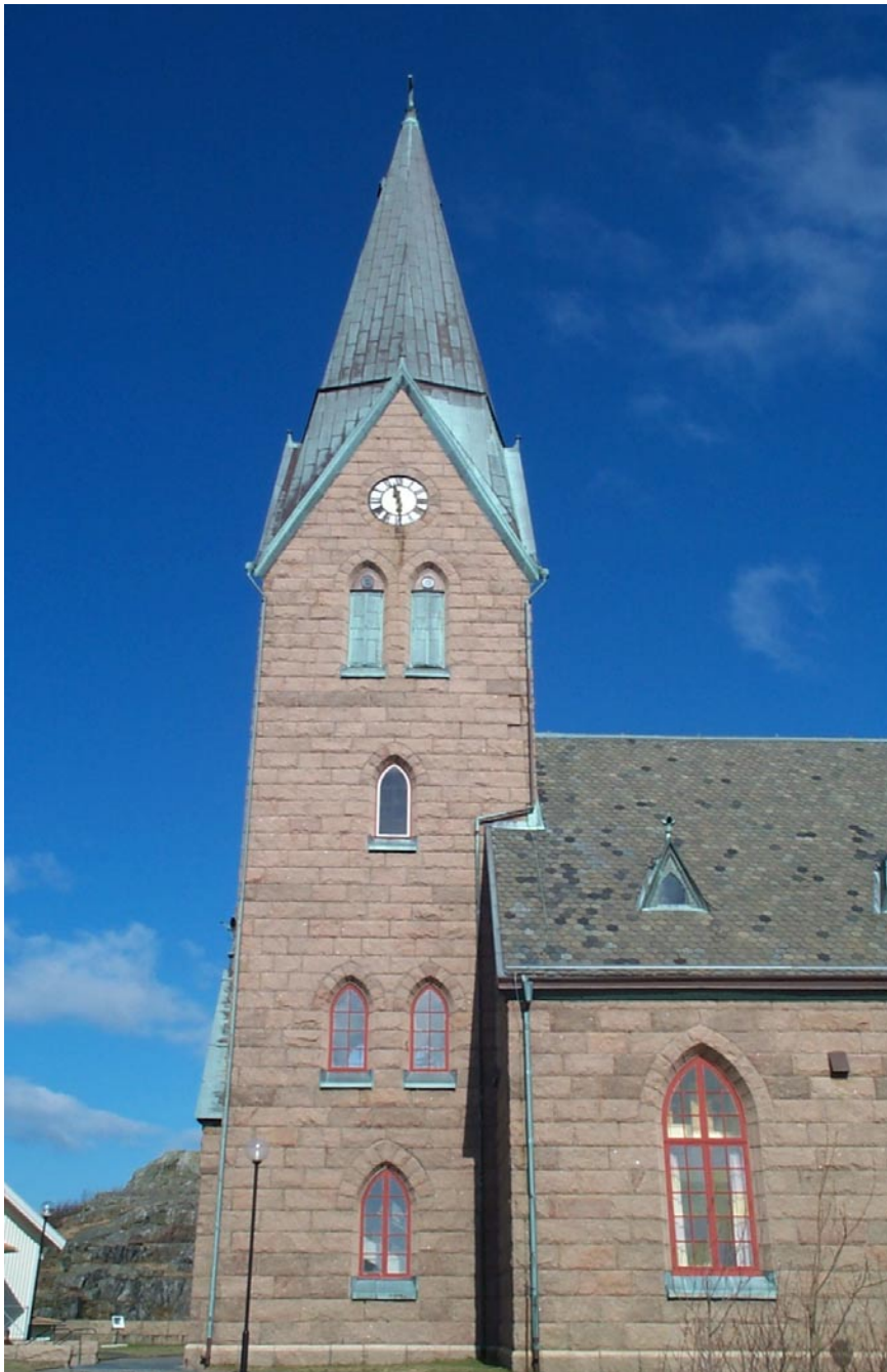
Kyrktornet från söder, före reparationer.
