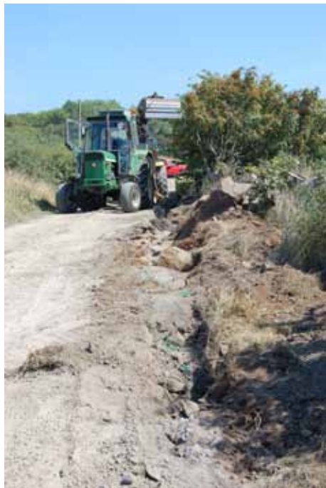
Figur 3. Sprängningsarbete 2006-07-26. Foto: Per Falkenström.
