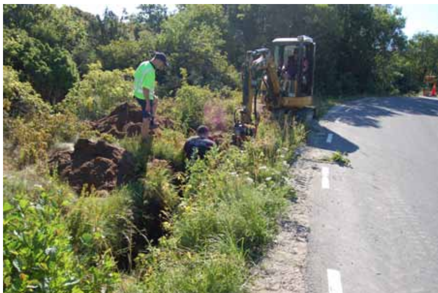
Figur 4. Schaktning vid Vråstigen. Foto: Mattias Öbrink.
