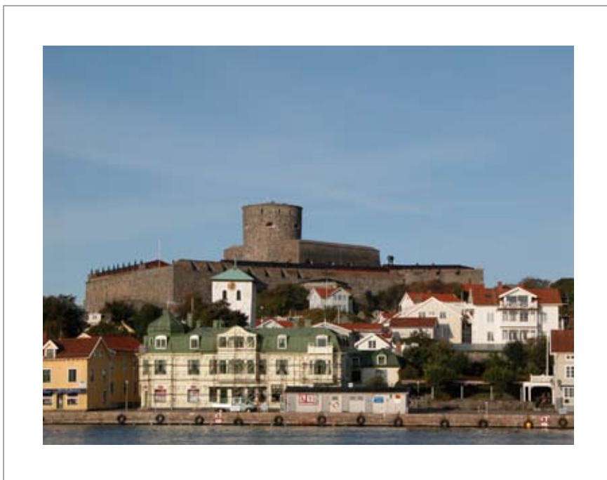
Figur 3. En del av den långa stenkajen på Marstrandsön som var i behov av stabiliseringsåtgärder. Vy mot väst. Karlstens fästning tronar över den lilla staden. Foto: Inger Nyström Godfrey, Studio Väst-svensk Konservering.
