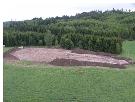
Figur 2. Översiktsfoto över den norra delytan efter avbaning. Foto mot söder.
