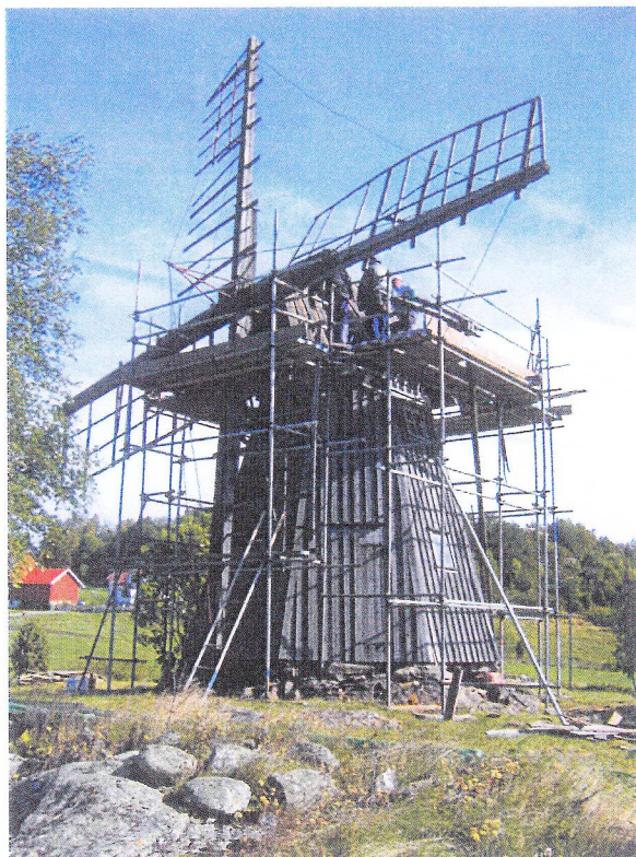
Kvarnen före nedtagning av vingar och panel
