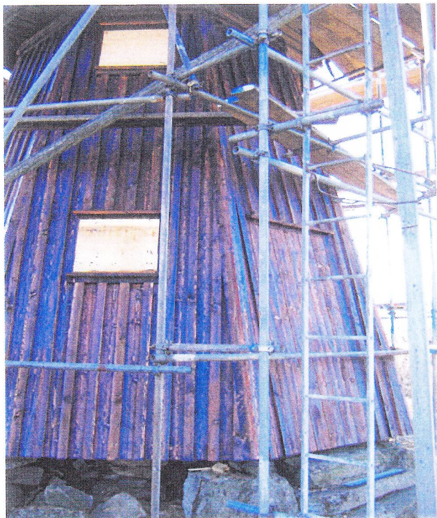
Bytt panel samt tjärad två gånger.
