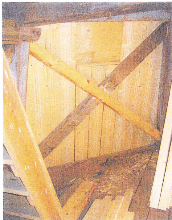
Interiör: Snedstag bytt samt ny panel uppsatt. Obs! den spårade panelen.
