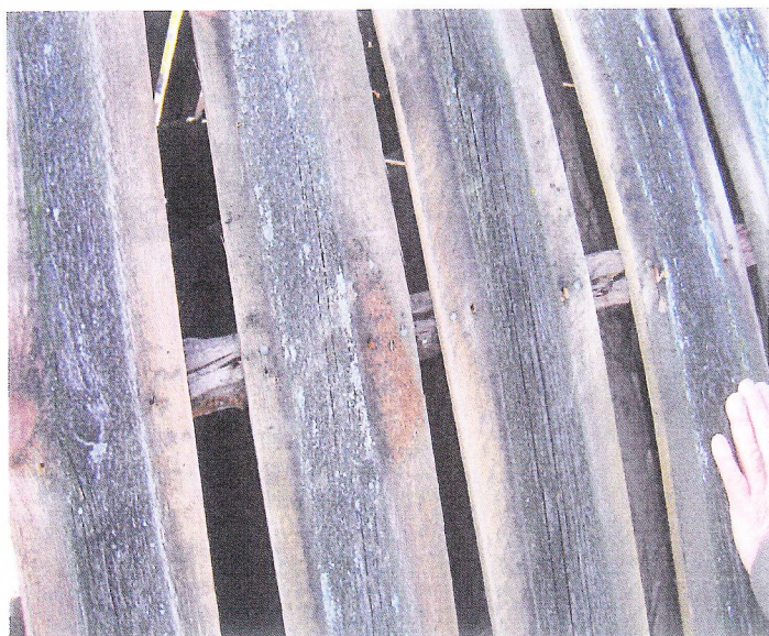
Takkonstruktionen med ytterbrädor samt klint konstruktionsvirke.
