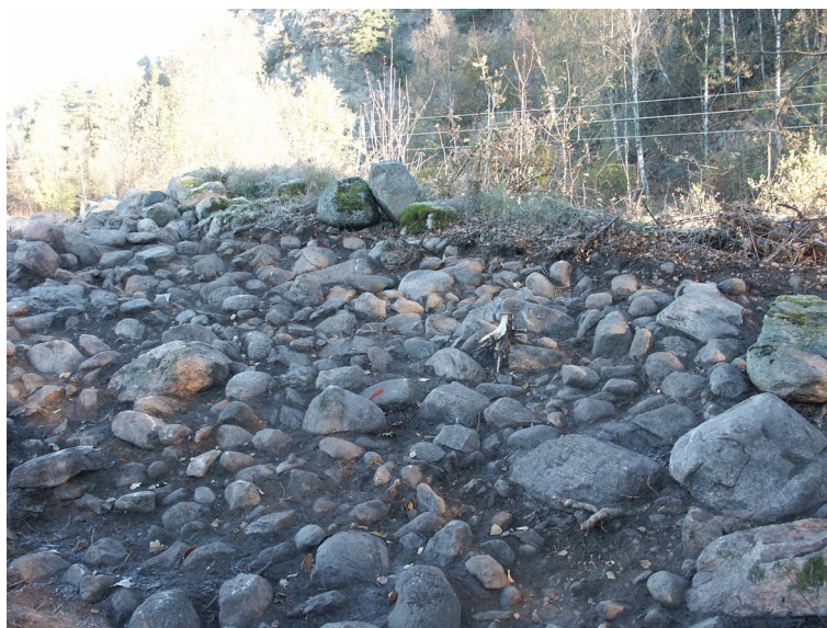
Fig. 74 Översta stenlagret samt delar av stenmanteln synlig på kanten av RAA 240. Bilden tagen från VSV. Foto: Gundela Lindman.
