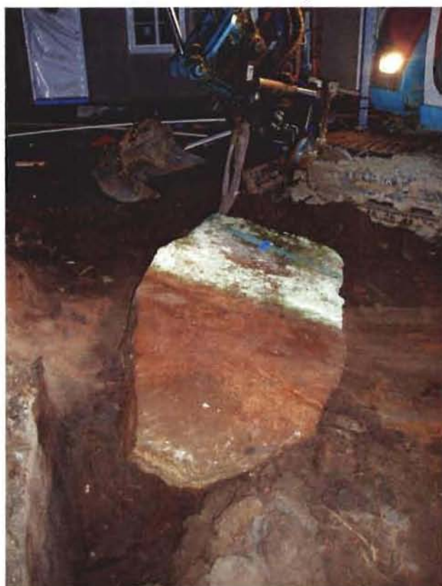
Figur 6. Det varsamma lyftet gjorde att stenpackningen kring stenblocket stördes minimalt. Foto: Linnea Nordell.
