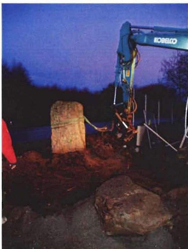
Figur 4. Förberedelser inför stenlyftet. Stenen ruckades ur läge med hjälp av grävmaskinen. Foto: Linnea Nordell.
