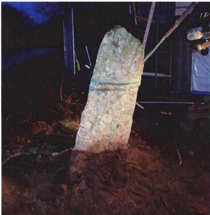
Figur 5. Stenen börjar ge med sig när grävmaskinen drar och lyfter den ur sitt ursprungliga läge. Foto: Linnea Nordell.
