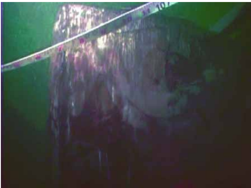
Bild 18 En kraftig däcksstötta frilagd i provschakt 2.
