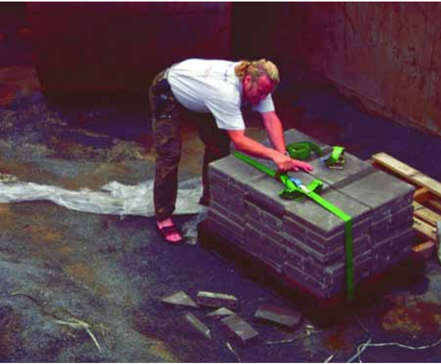
Bild 11 En av flera pallar med betongplattor som användes för preliminär viktning av gummiduken.
