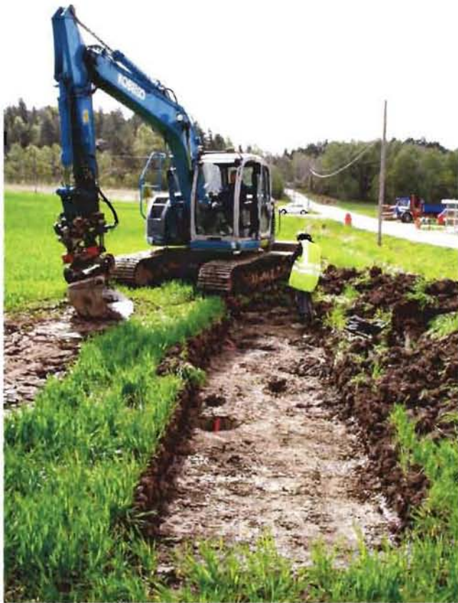
Arbetsbild vid schakt 49, från norr. Foto: Susanne Selling.
